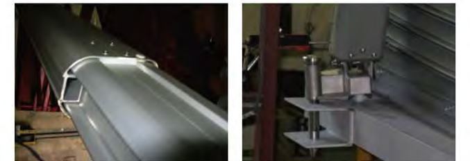
写真 2 シャッター補強部材の詳細（連結部と床ピン）
